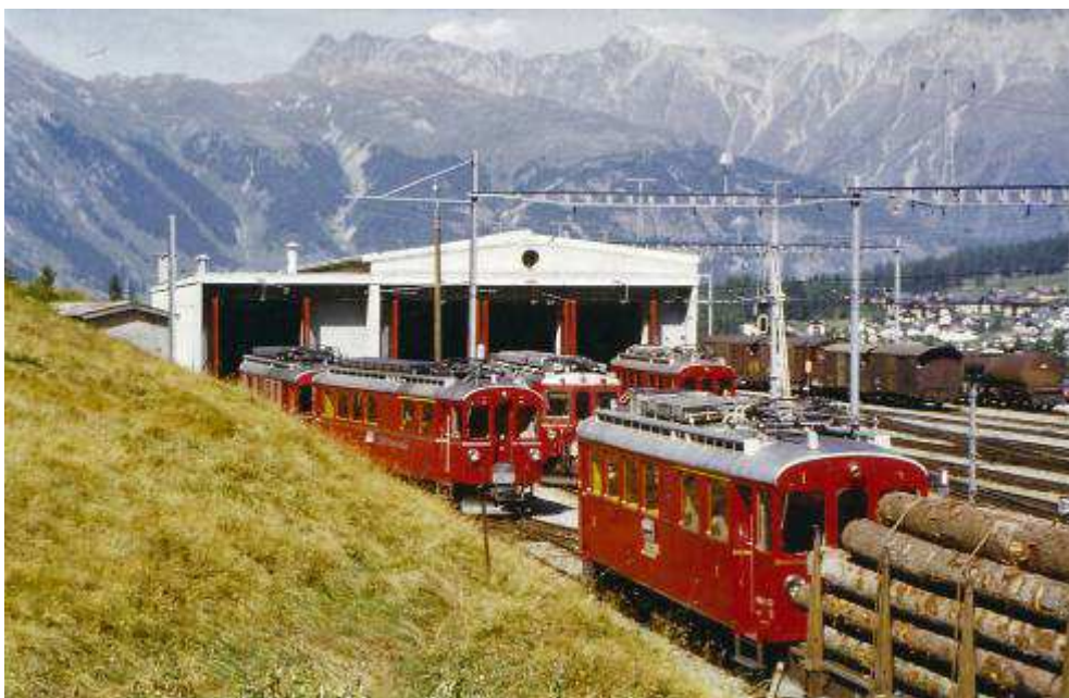
Berninabahn-Depot Pontresina 1989 Foto H.P. Bärtschi
