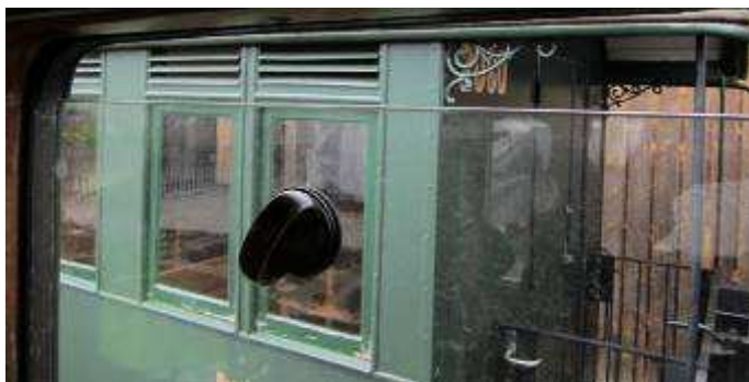
Im Vordergrund rahmenloses Senkfenster mit Originalbeschlag des A 1102, dahinter typische RhB-Jalousielüfter und Fenster mit Holzrahmen des B 2060 Landquart 2013
