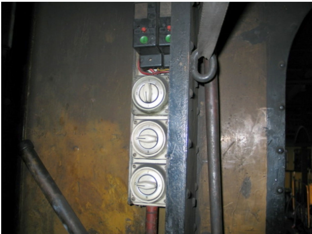
Das Elektrotableau mit den zwei Sicherungen und den Lichtschaltern
